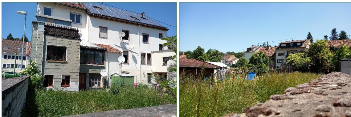
Abbildung 19 und 20: Wohngebäude der Völklinger Straße Nr. 20 mit angrenzender Gartenbrache (links) und Blick auf die Ufergehölze des Lauterbaches (rechts) (Quelle: ARGUS CONCEPT GmbH)
