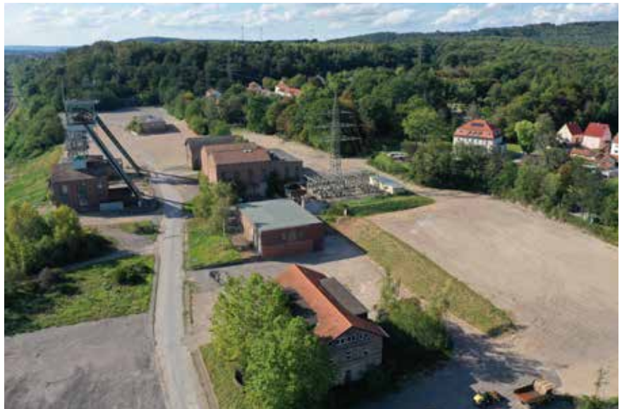
Brachliegende Fläche der ehem. Tagesanlage
