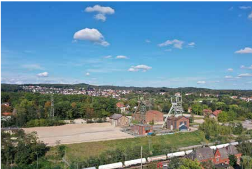
Blick auf das Areal der ehem. Tagesanlage
