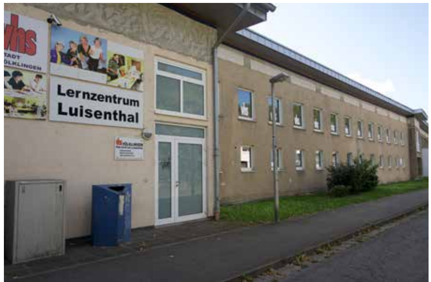
VHS-Zweigstelle im Bereich der Neuen Straße
